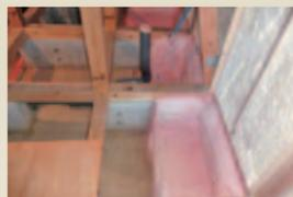
“隙間なし”がポイント。住宅を丸ごとしっかり包む断熱材。断熱力・気密力でさらなる省エネ効果を発揮します。
